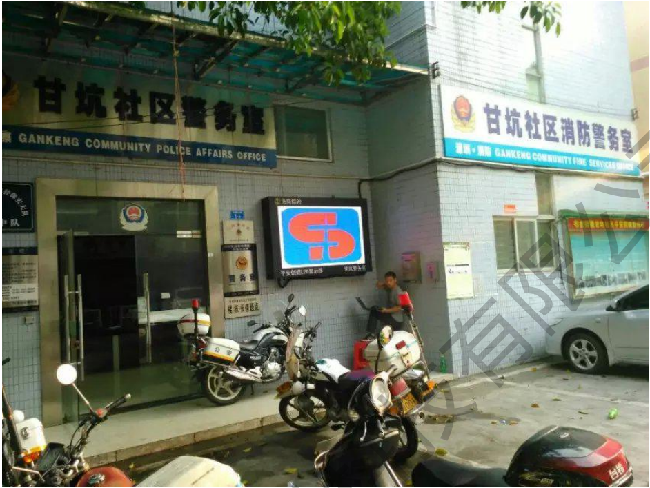
深圳某地项目
